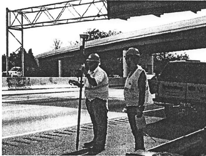
gambar 2. 5. Pengukuran layout jalan secara real time kinematik menggunakan Trimble 5800 RTK GPS system
