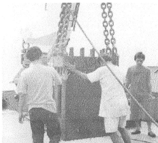
Gambar 2.20: Pemasangan Dredger untuk Mengeruk Sedimen Dasar Laut
