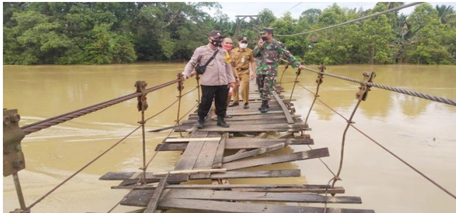
Gambar 1.2 Jembatan gantung yang rusak terkena banjir di Kecamatan Kalua yang terjadi pada tanggal 30 November 2021
