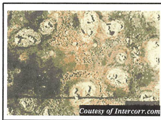
Gambar 2.3 Korosi Sumuran. Sumber : Delina, 2007.
