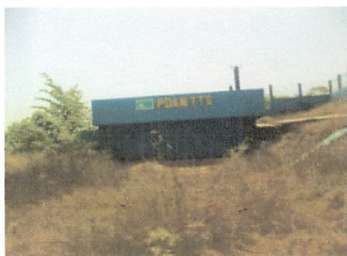
Gambar 4.7. Reservoir Bu'at Kapasitas Tampung 500 m 3 (Dokumentasi, 2011)
