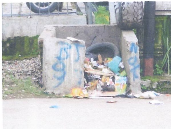
Gambar 4.3. Pewadahan Jenis Pasangan Batu
