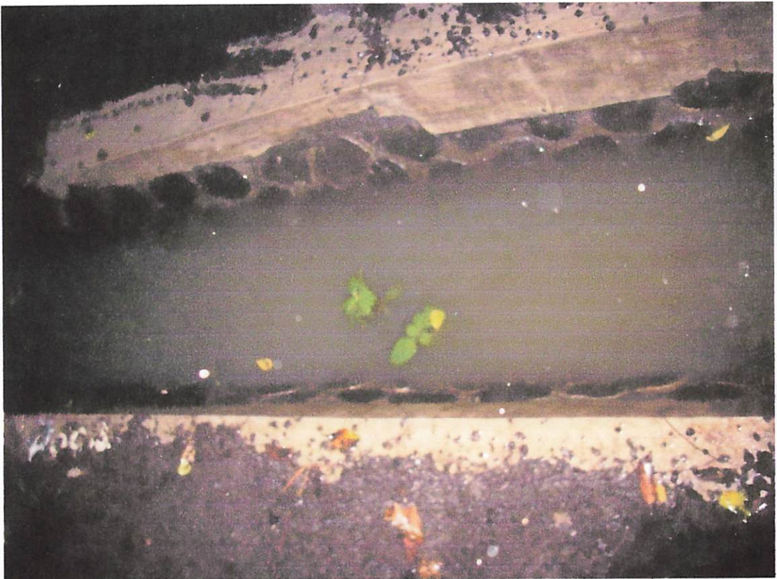
Saluran Drainase Panji Suroso
