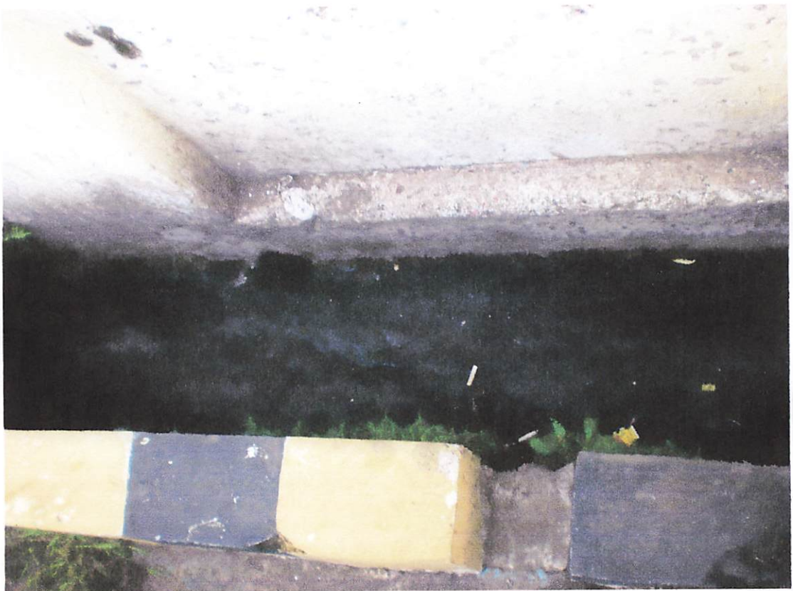
Saluran Drainase Plausan Timur Kanan
