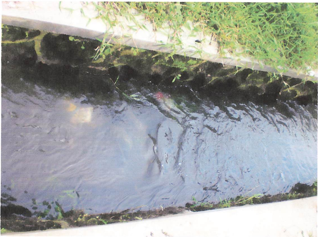
Saluran Drainase Sulfat Utara Kiri
