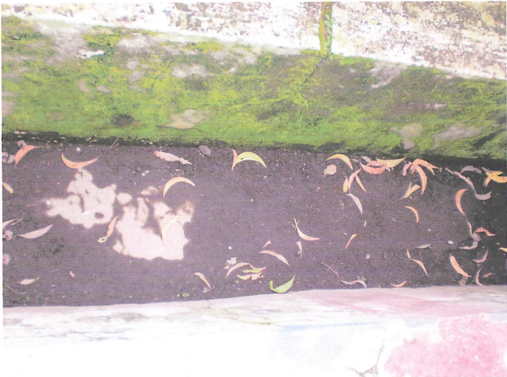
Saluran Drainase Kalimosodo Kanan
