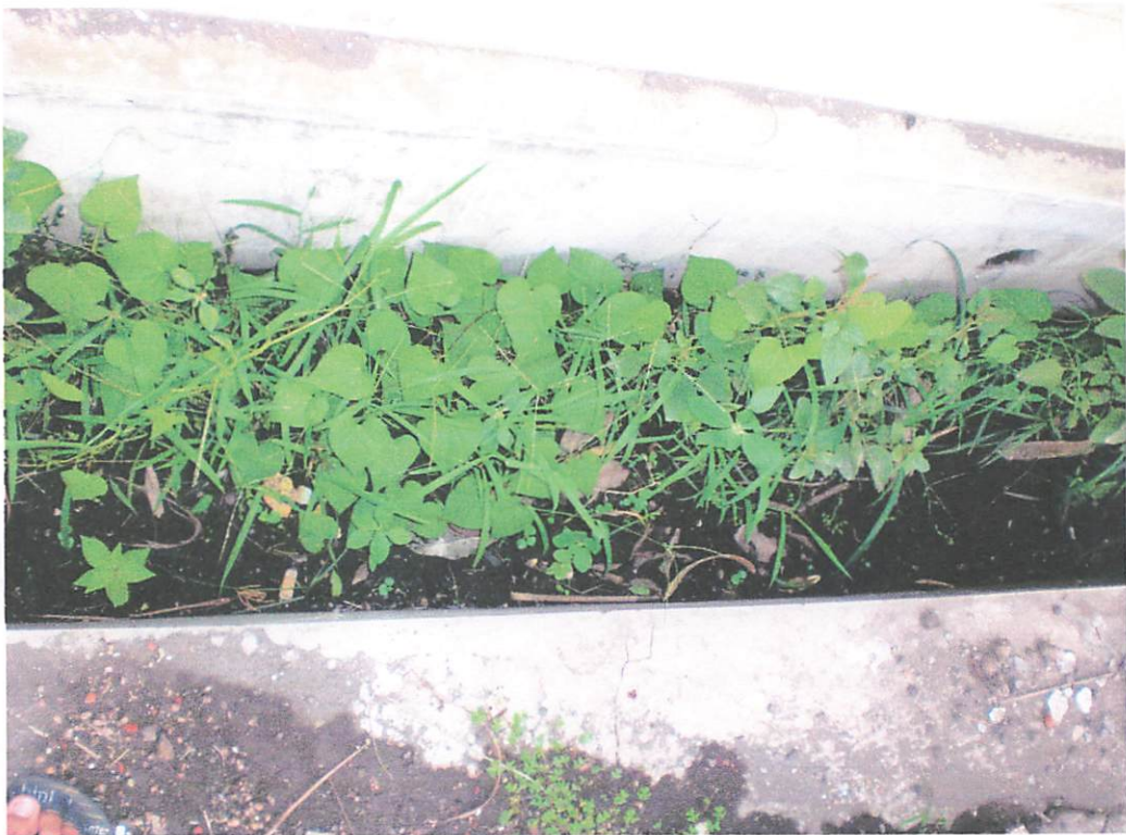
Saluran Drainase Indraprasto Kanan
