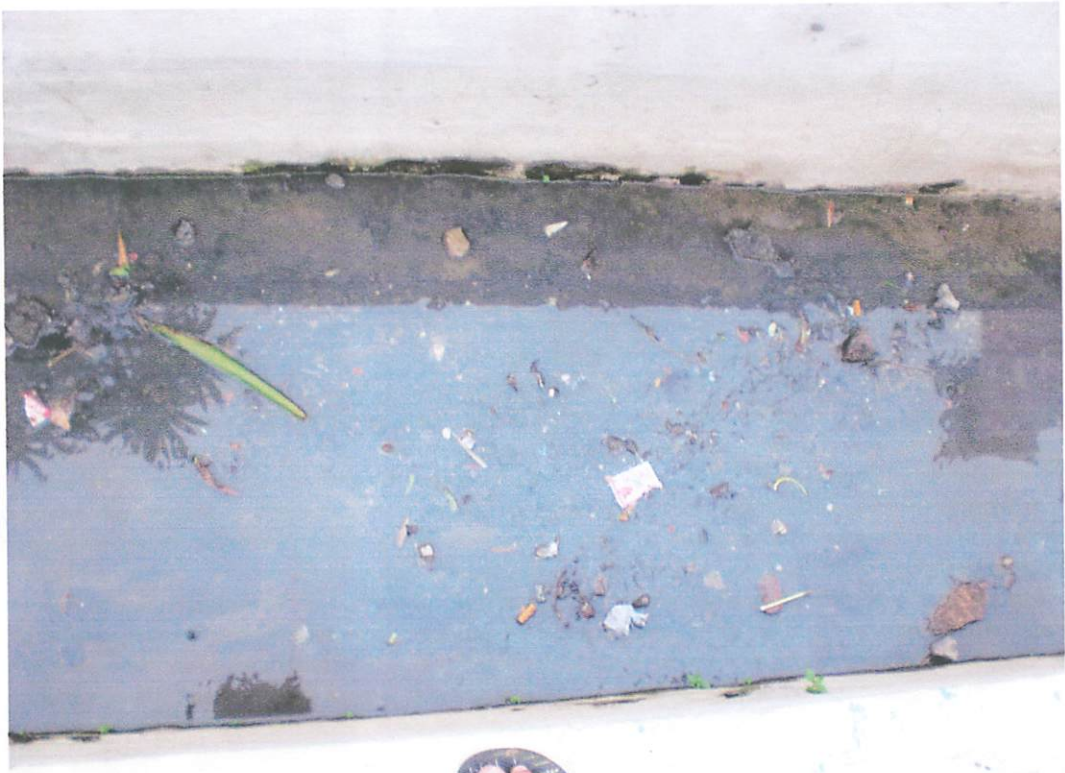
Saluran Drainase N akulo
