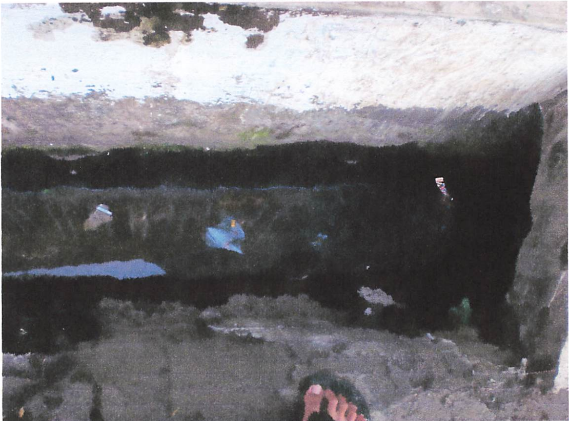
Saluran Drainase Puntodewo Kanan
