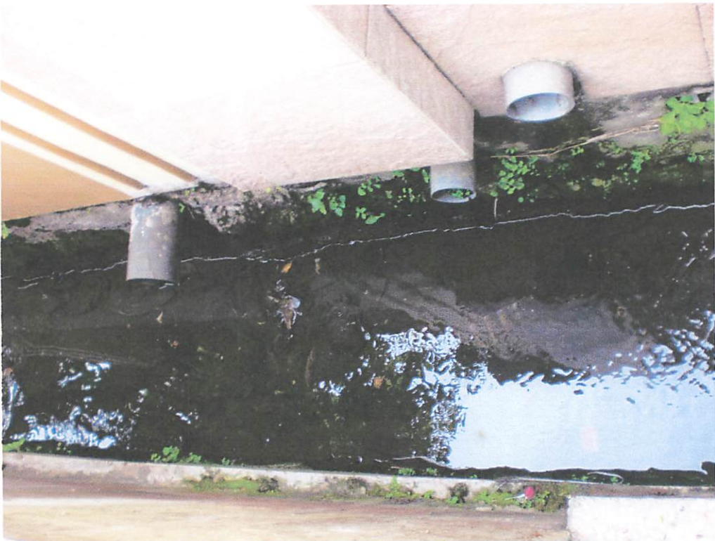
Saluran Drainase Emas Kanan
