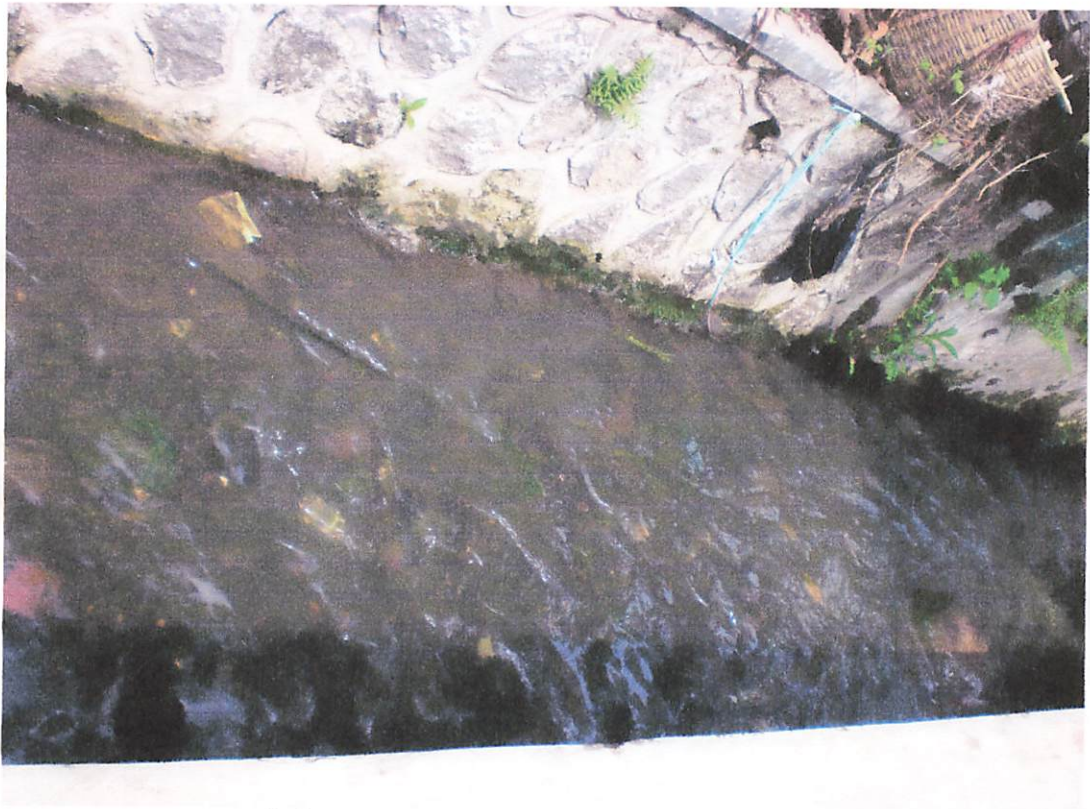
Saluran Drainase Teluk Grajakan Kiri
