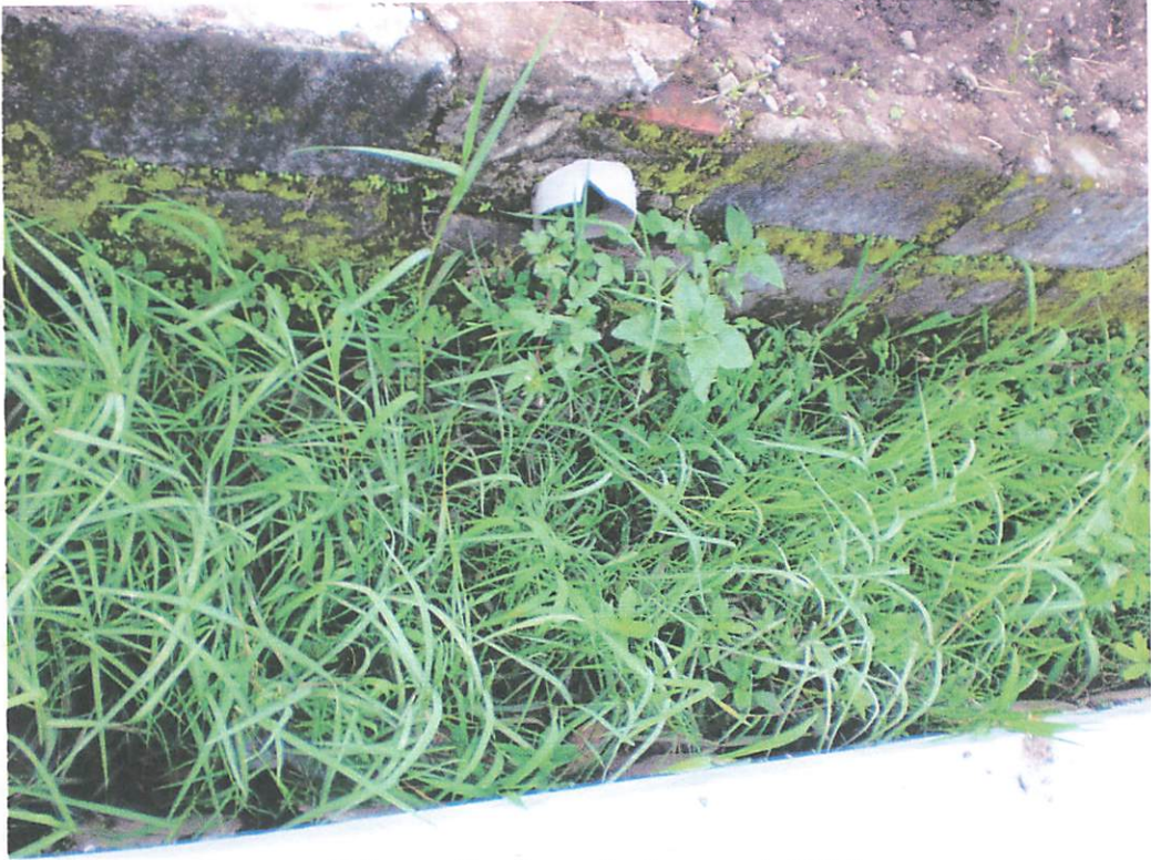
Saluran Drainase Indraprasto Kiri
