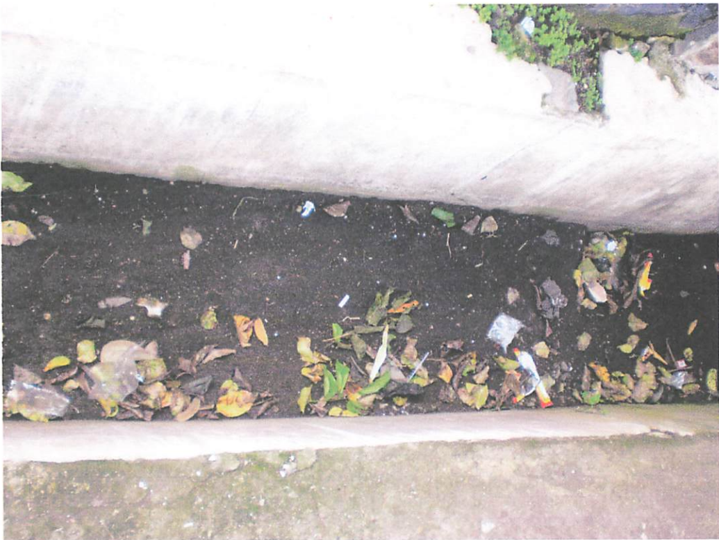
Saluran Drainase Ksatrian Kanan
