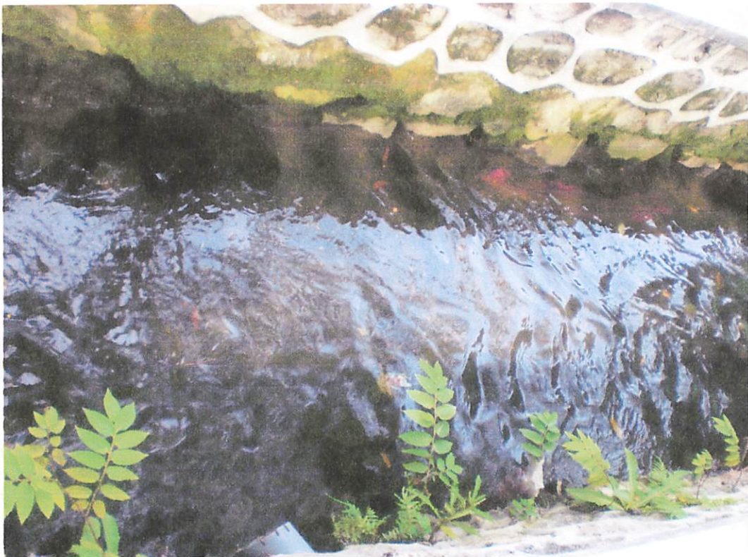
Saluran Drainase Titan Asri Tengah
