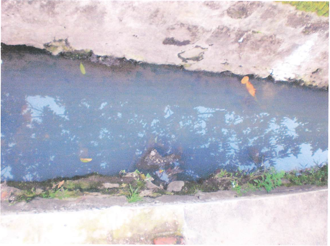
Saluran Drainase Sadewo
