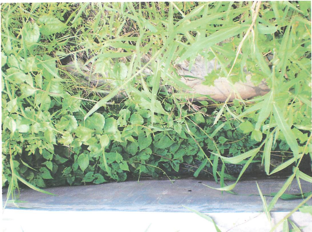
Saluran Drainase Memberamo Kanan
