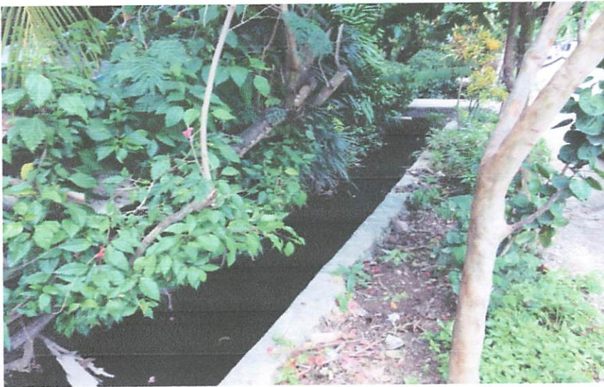
Gambar 4.14 : Saluran yang ada di area pemukiman Kecamatan Kadia
