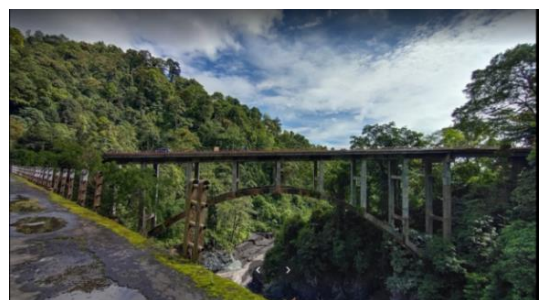
Gambar 3. 2 Kondisi Eksisting Jembatan
