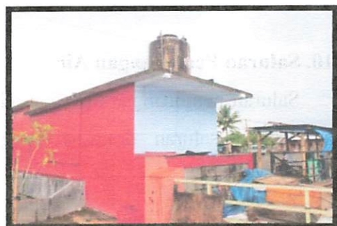
Gambar 4.16 Penyediaan Air Bersih Sumber : Survey Lapangan, 2013
