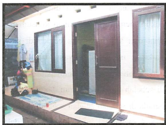
Gambar 4.10 Mushola di sebelah utara Sumber : Survey Lapangan, 2013
