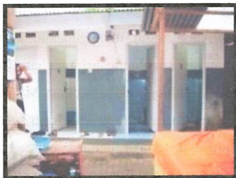
Gambar 4.12 Toilet di dalam pasar
