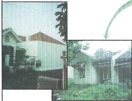
Kondisi tembok batu bata dengan finishing cat
