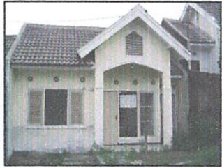
Kondisi jendela yang mengalami perubahan
