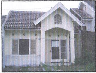
Kondisi jendela yang mengalami perubahan
