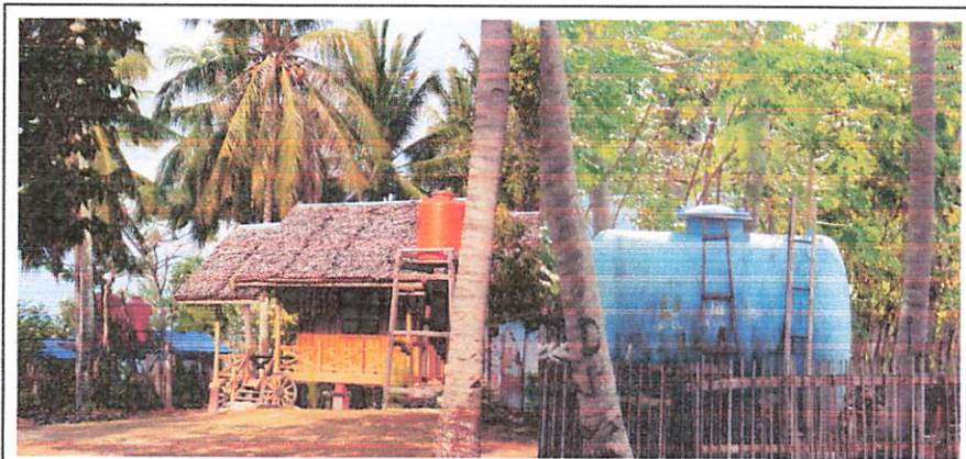
Gbr. 2.8. Hidran dan bak penampungan air yang ada di lokasi objek wisata Tanjung Karang
