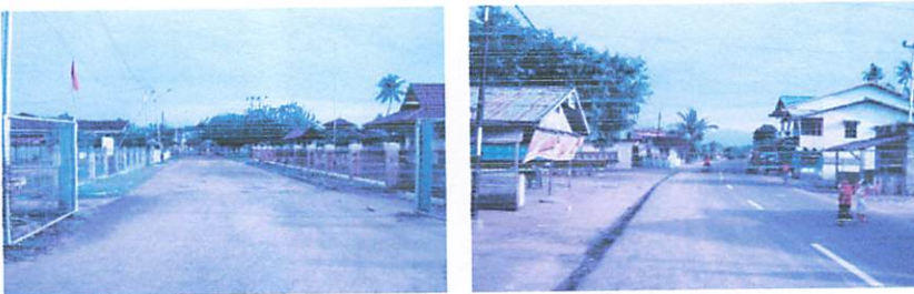
Gambar 5.18 Jalan Utama Pelabuhan
