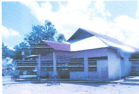
Gambar 4.7 Terminal penumpang pelabuhan Suka Bangun
