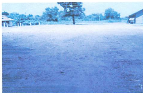
Gambar 5.9 Lapangan Penumpukan Pelabuhan Suka Bangun
