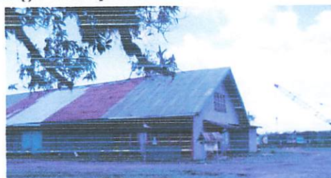
Gambar 5.15 Gudang Penumpukan Pelabuhan Suka Bangun
