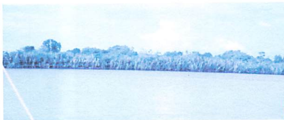
Gambar 4.2 Penahan Gelombang Pelabuhan Suka Bangun
