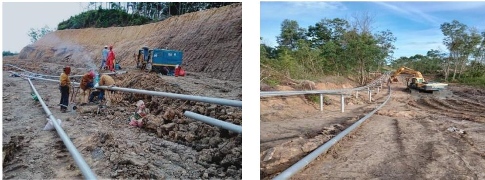
Gambar.1.1 Pekerjaan pengelasan pipa dan *line up* pipa to *pipe support*
