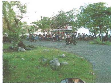
Gambar 2.13 Kondisi Jalan Aspal →
