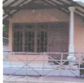
Foto 2.13 Perumahan Penduduk Asli dengan arsitektur modern Sumber : Hasil Survey
