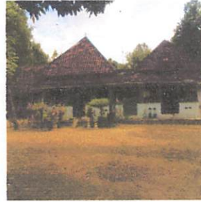
Foto 2.20 Model Bangunan Dengan Susuran Samping Sumber : Hasil Survey
