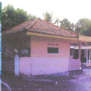
Foto 2.15 Rumah dengan ruang antar tetangga berupa tembok halaman belakang Sumber : Hasil Survey
