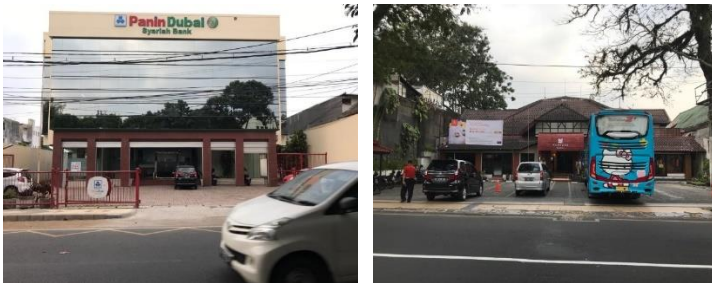
Gambar 5.6 Bangunan Dengan KDB 64 %
