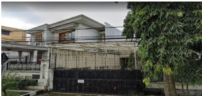
FOTO KONDISI EKSISTING JL SUROPATI
