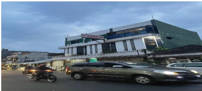
FOTO KONDISI EKSISTING JL. ZAINUL ARIFIN
