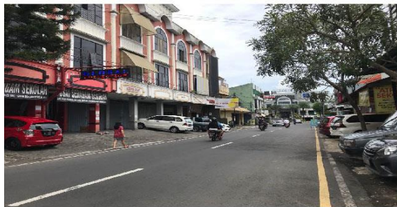
FOTO KONDISI EKSISTING JL ZAINUL ARIFIN
