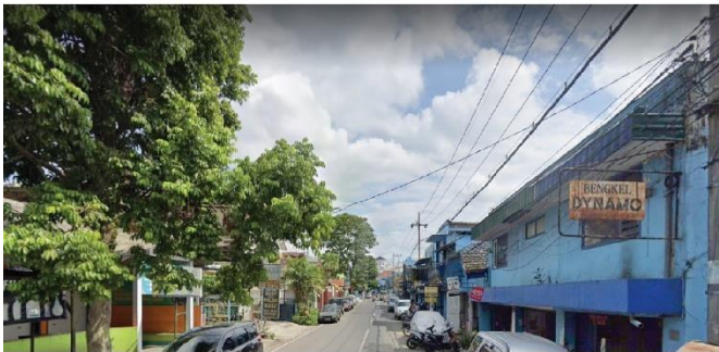
FOTO KONDISI EKSISTING JL ARIES MUNANDAR
