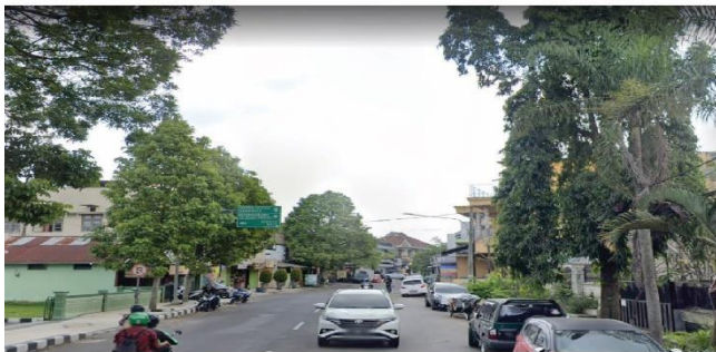
FOTO KONDISI EKSISTING JL SUROPATI
