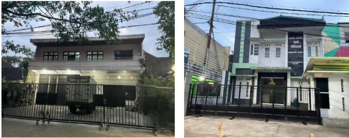
Gambar 5.5 Bangunan Dengan KDB 70 %
