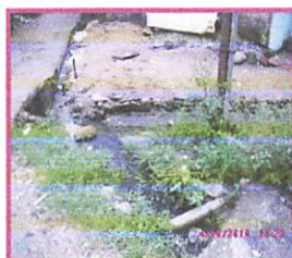
Kondisi saluran drainase berupa tanah dan pondasi semen
