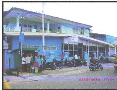
Gambar 2.1 Bangunan Fasilitas Kesehatan
