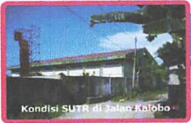
Kondisi SUTR di Jalan Kalobo
