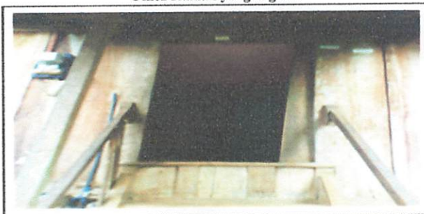
Gambar 2.21 Pintu Rumah yang Digeser
