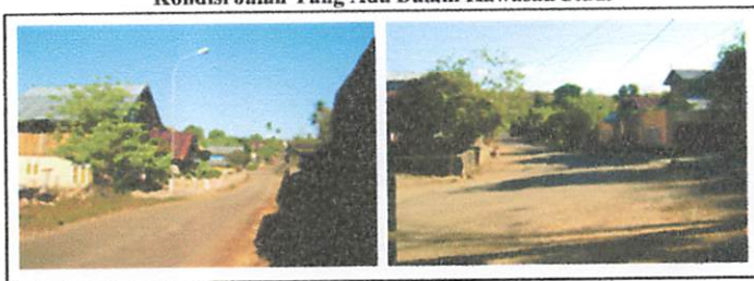
Gambar 2.27 Kondisi Jalan Yang Ada Dalam Kawasan Studi
