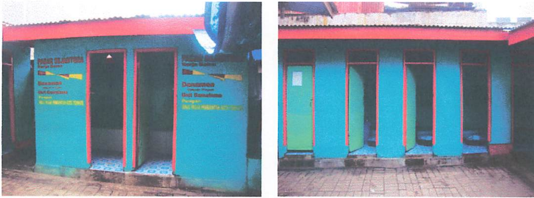
Gambar 5.2 Kondisi Eksisting Toilet di Pasar Gamalama
