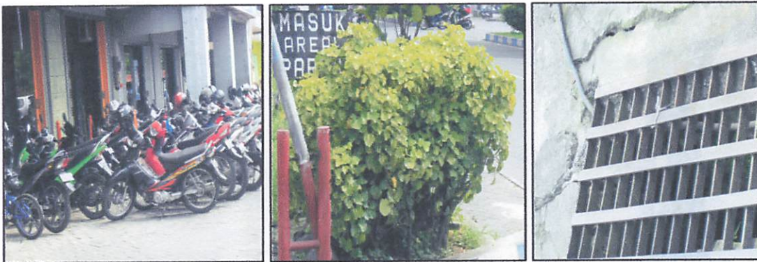
Gambar 4.3 Kondisi lingkungan pada lokasi studi Sumber: Hasil Survey tahun 2011
