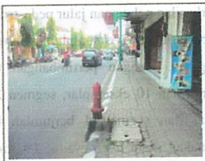
Foto 4.19 Hidrant Kebakaran Lokasi : A. Depan Toko Optik 99 Sumber : Hasil Survey, 02/03/2013
