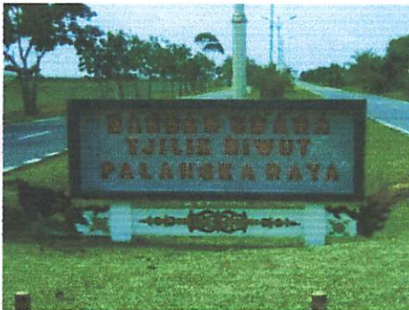
Kondisi jalan menuju Bandar udara Tjilik Riwut
