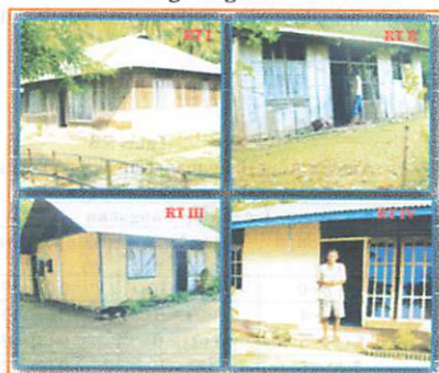
Gambar 5.2 Dinding Bangunan Desa Waka
