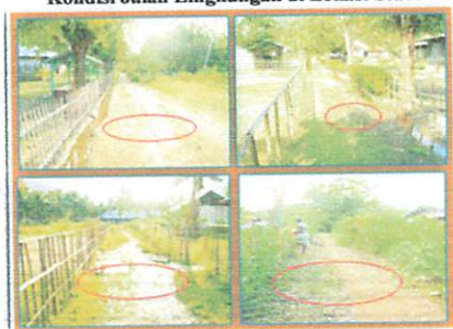
Gambar 4.9 Kondisi Jalan Lingkungan di Lokasi Studi
