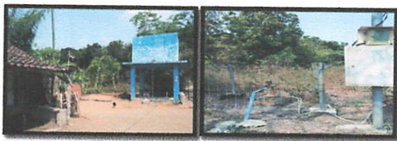
Gambar 4.3 Kondisi SPAM Desa Jatirejo, Desa Manguna
