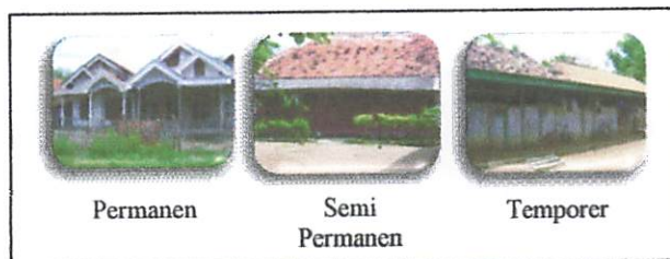
Gambar 2.1 : Kondisi Bangunan di Desa Gulbung
