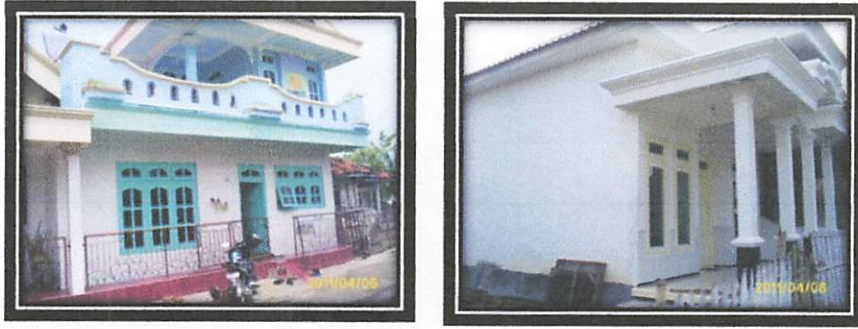
Gambar 4.5. Kondisi Dinding Permanen
