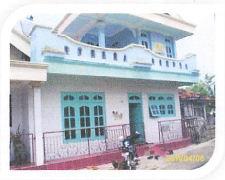
Gambar 4.8. Kondisi ventilasi yang memadai
