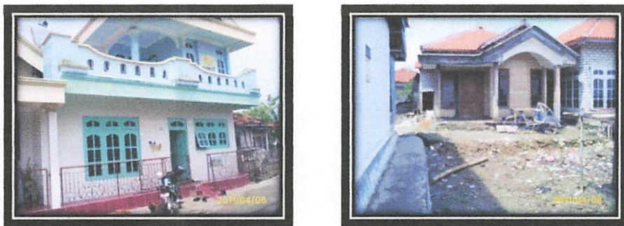
Gambar 4.3. Kondisi Rumah Dusun Dhalem
