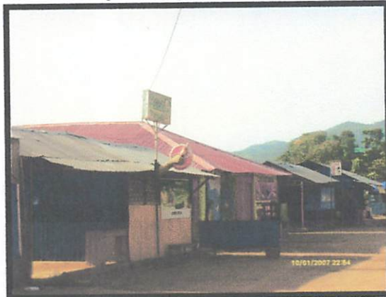
Gambar 2.3 Sarana jual bangunan non permanen
