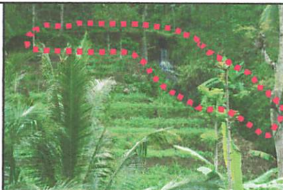
Gb 2.13 Saluran irigasi tersier yang rusak Sumber : Dokumentasi Pribadi Sep.2010
