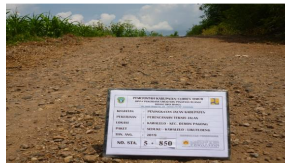
Gambar 3. Situasi Kondisi Eksisting Ruas Jalan Sp. Seduku-Kawalelo-Likutudeng-Lamika
