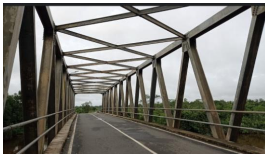
Gambar 4.6.15 Jembatan Pulau Kupang / 'Km 1'
