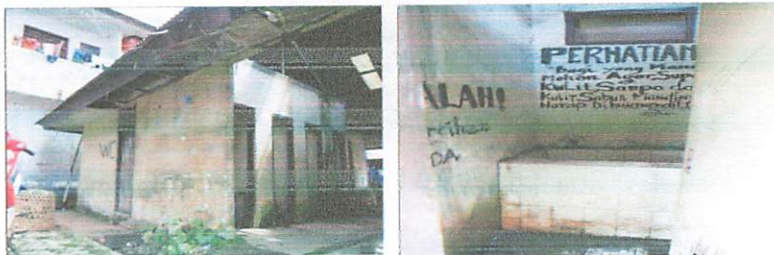
Gambar 4.10 Fasilitas Toilet di Pasar Bolu
