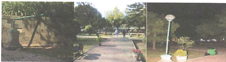
Gambar 1.1 Permasalahan Lampu Taman Sumber: Hasil Survey November 2014
