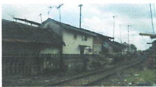
Kondisi permukiman di sepanjang sempadan rel kereta api
