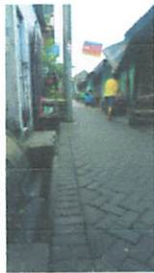
Kondisi infrastruktur drainase permukiman yang ada di sepanjang sempadan rel kereta api
