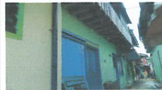
Kondisi permukiman di sepanjang sempadan rel kereta api
