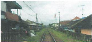
Kondisi permukiman di sepanjang sempadan rel kereta api
