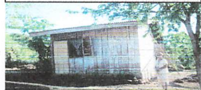
Gambar 2.33 Kondisi Lahan Tapak Rumah Translok Wateng
