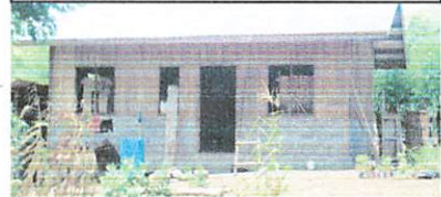
Gambar 2.34 Kondisi Lahan Tapak Rumah Translok Waijarang
