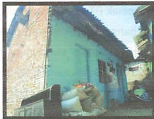
Gambar 4.6 Kondisi Bangunan Cukup Baik RT 3 Sumber : Hasil Survey 2013
