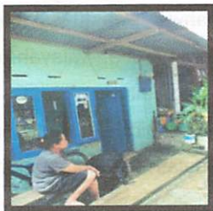
Gambar 4.5 Kondisi Bangunan Cukup Baik RT 2 Sumber : Hasil Survey 2013
