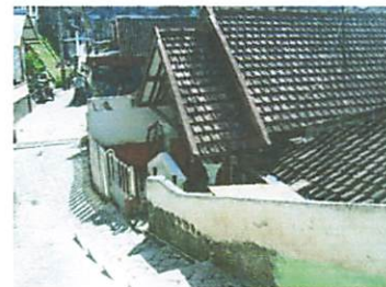
Gambar 2 Atap Bangunan Campuran Antara Genteng Pelentong + Seng
