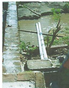
Gambar 9 Sistem Pembuangan Limbah Rumah Tangga Menggunakan Pipa Paralon Langsung Ke Sungai
