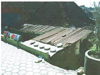
Gambar 1 Atap Bangunan Menggunakan Genteng Pelentong
