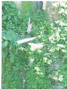
Gambar 9 Sistem Pembuangan Limbah Rumah Tangga Menggunakan Pipa Paralon Langsung Ke Sungai
