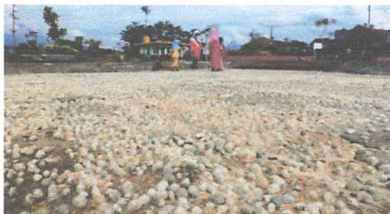
Gambar 4. 3 Kondisi Jogging Track di Taman Singha Merjosari
