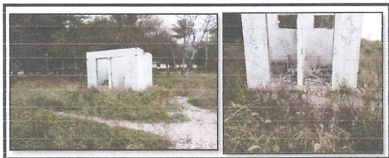
Gambar 4.14 Toilet Umum di Wisata Pantai Kolbano
