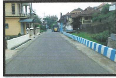
Gambar 4.3. Kondisi Jalan Desa Aspal
