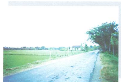
Foto 2.1. Ruas Jalan Kab. Bima
