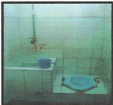
Gambar 4.44 Kondisi Kamar kecil
