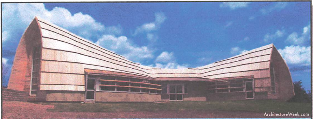
Mi'kmaq Tradisional praktek bangunan yang diadaptasi untuk digunakan dalam pembangunan pusat kesehatan, terletak di Pictou Landing First Nation
