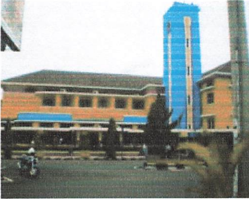
G. Perkantoran (PLN) dengan ketinggian bangunan 2 lantai
