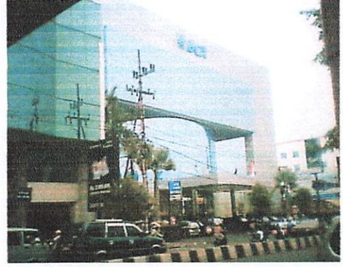
F. Bank BCA dengan ketinggian bangunan 6 lantai
