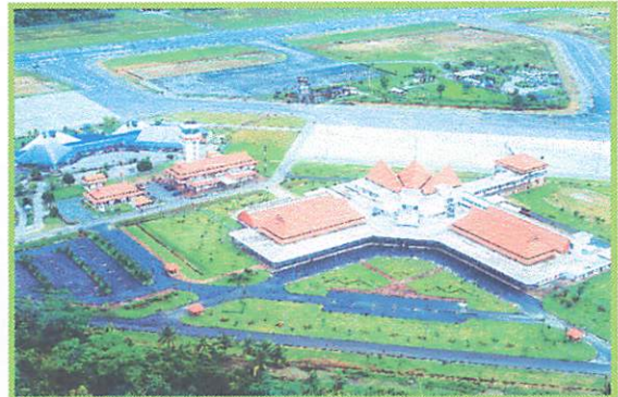
Gambar 3.4. Terminal Penumpang Bandar Udara Pattimura
