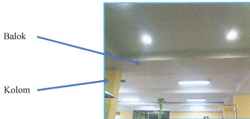
Gambar 2.27 kolom dan balok sebagai struktur bangunan perpustakaan umum kota Malang
