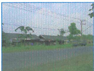
Fasilitas terminal di Driyorejo
