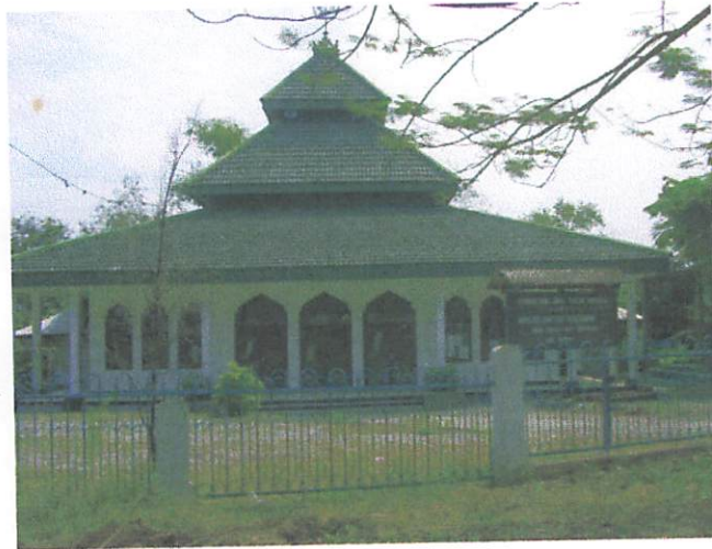
Gambar 2.3. Fasilitas Peribadatan Di Driyorejo
