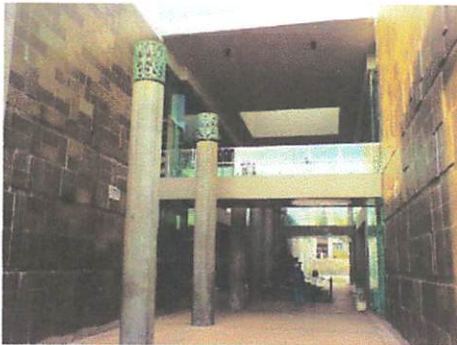
Gambar 2.9 Koridor yang berupa jembatan
