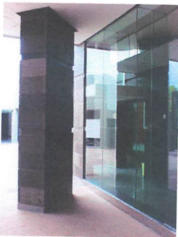
Gambar 2.7 Kolom beton yang dilapisi batu alam (batu candi) digunakan sebagai penyokong koridor yang menyatukan antara gedung A dan gedung B.
