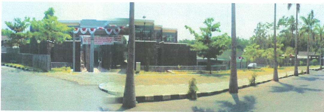
Gambar 2.5 Suasana ruang luar di sebelah selatan
