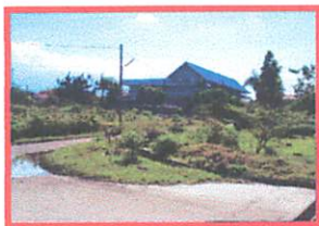
Tampak dari arah utara/belakang site perumahan griya santa.
