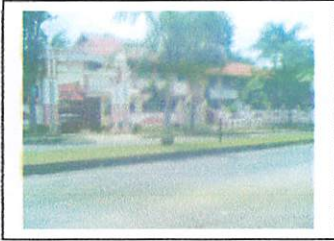
Bangunan SMUN 9 Sebagai salah satu fasilitas pendidikan
